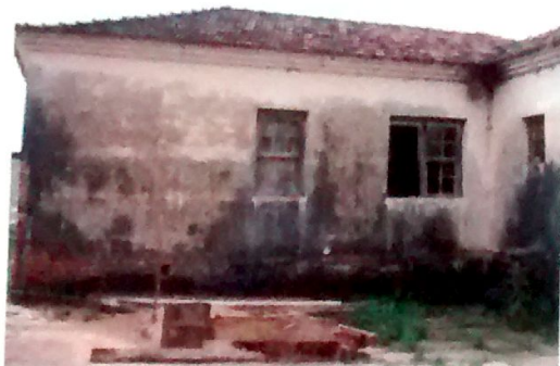
Foto 03- Fachada posterior da edificação Município de São Thomé das Letras – MG Adane Soares Marques | março - 2009
