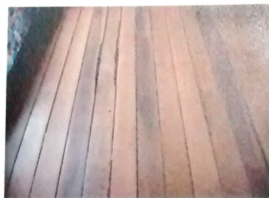
Foto 04- Piso de madeira de um dos quartos Município de São Thomé das Letras – MG Adane Soares Marques | março - 2009
