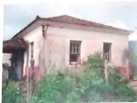
Foto 02- Fachada lateral da edificação Município de São Thomé das Letras – MG Adane Soares Marques | março - 2009
