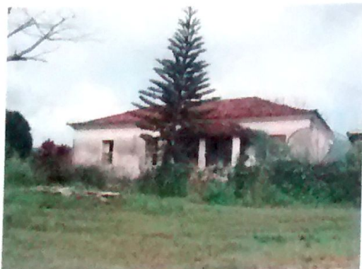
Foto 01- Fachada frontal da edificação Município de São Thomé das Letras – MG Adane Soares Marques | março - 2009
